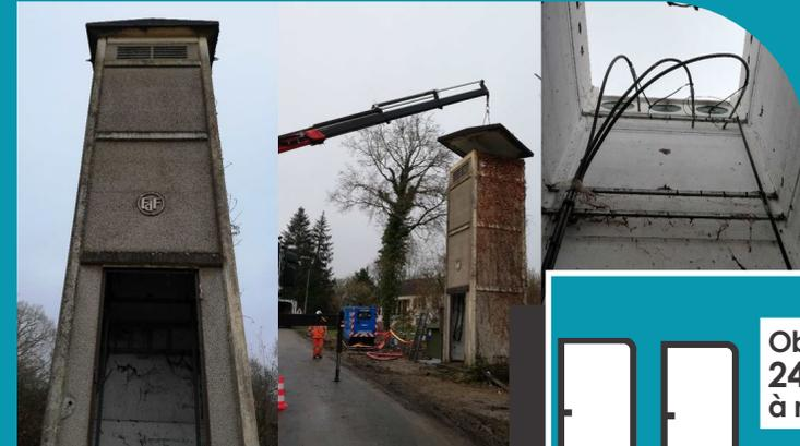
Bâties entre les années 1920 et 1960, les cabines hautes sont les postes les plus anciens du réseau. Leur structure en béton armé sert à protéger les fils électriques aériens descendus à hauteur d'homme en conducteur nu.
