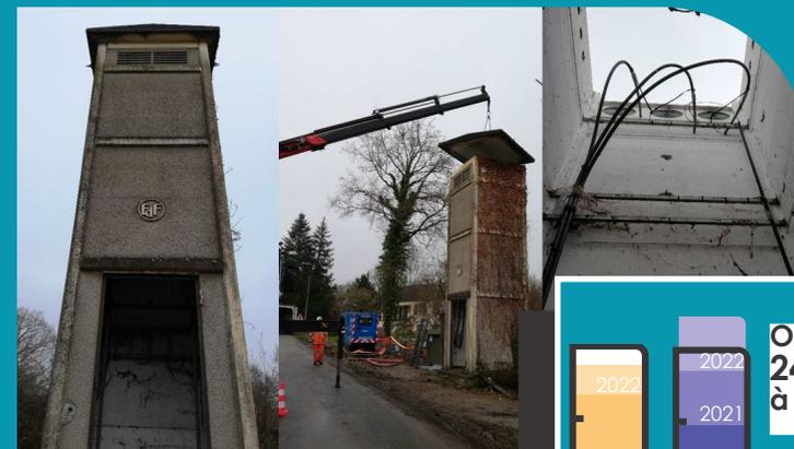
Bâties entre les années 1920 et 1960, les cabines hautes sont les postes les plus anciens du réseau. Leur structure en béton armé sert à protéger les fils électriques aériens descendus à hauteur d'homme en conducteur nu.
