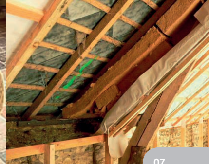
Isolation de toiture
