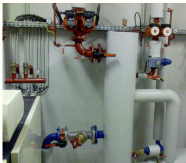
Installation de Chauffage
